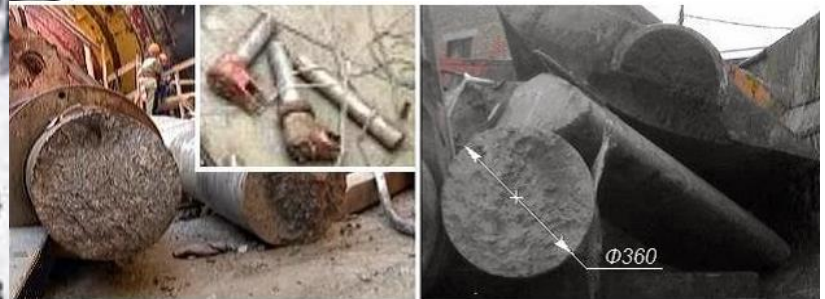
Рис. 12. Хрупкий излом верхних цапф стальных лопаток НА гидротурбины №2 СШГЭС
