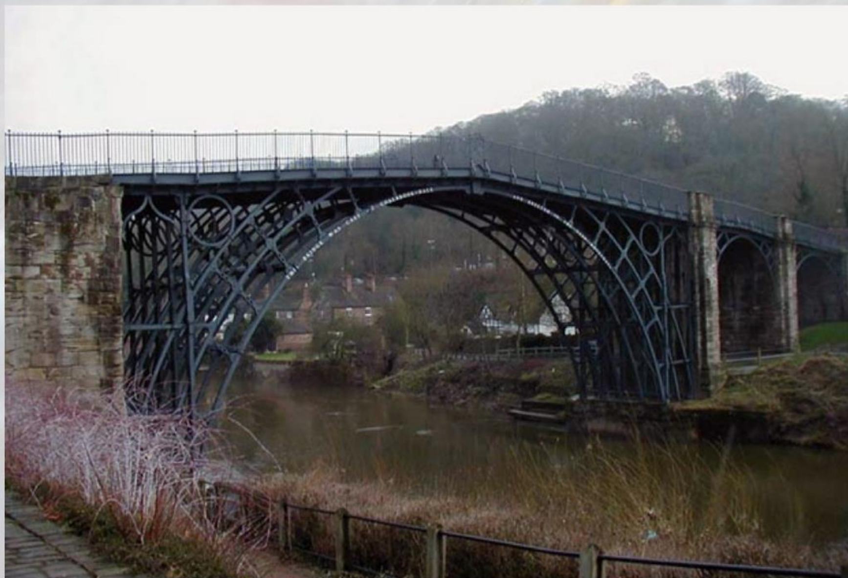
Первый железный мост, построенный в 1779 году. Его металлоконструкции выполнены из чугуна.
