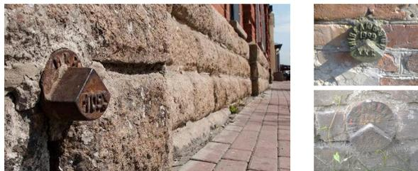
Рис. 4.5. Геодезические реперы, в совокупности, составляющие государственную нивелирную сеть (ГНС)
