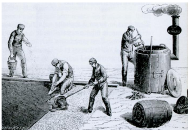
Рис. 1.7. Разогрев горячего литого асфальта и его укладка (1860 г.)
