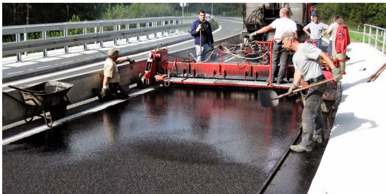
Рис. 9.6. Укладка литой асфальтобетонной смеси
