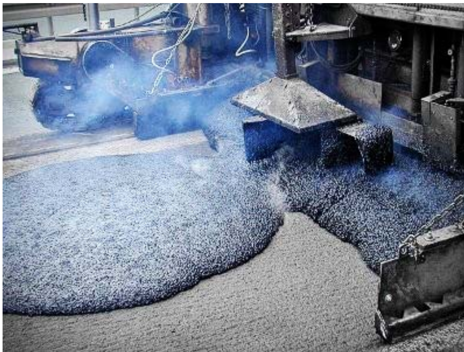
Рис. 9.4. Укладка литой асфальтобетонной смеси
