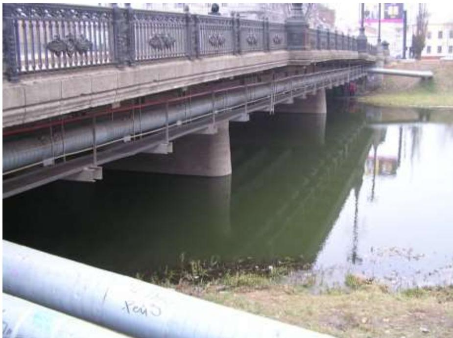
Рис. 1.17 Харьковский мост (на Московском проспекте). Подвеска к тротуару двух труб теплотрассы
