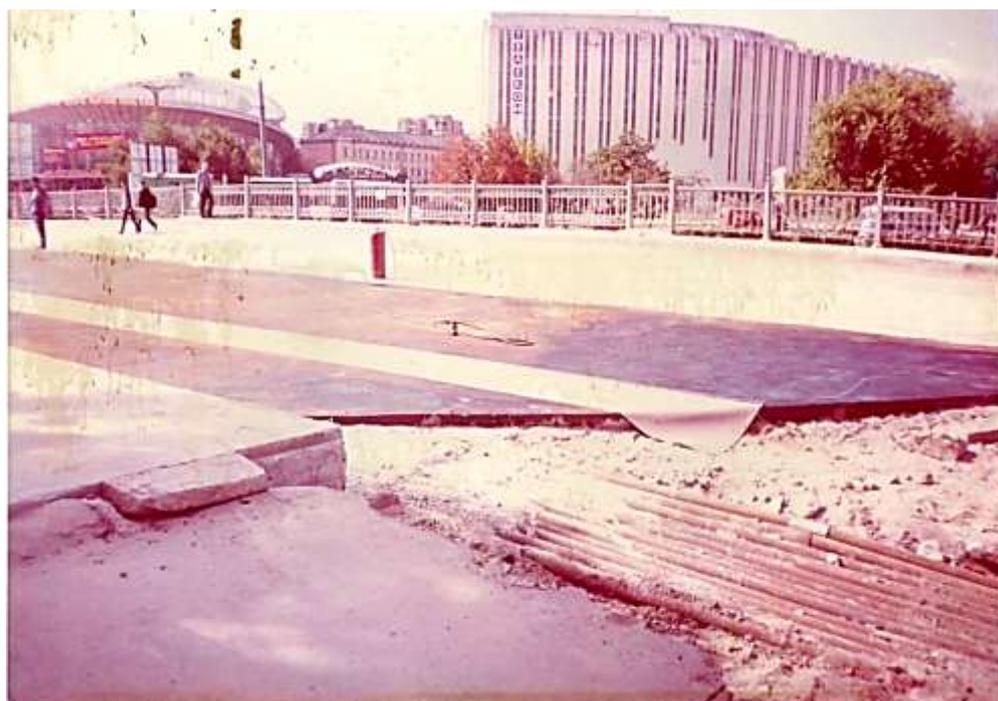
Рис.1.18 Нетеченский мост. Размещение 18 ниток городских телефонных кабелей под асфальтобетонным покрытием проезжей части
