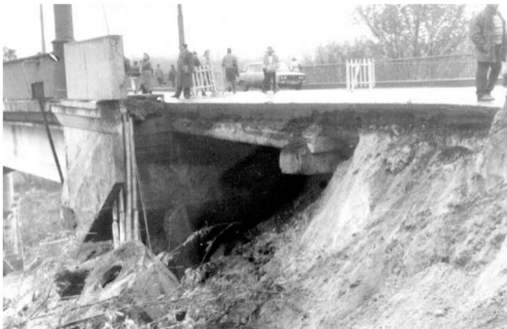
Рис. 1.15 Обрушение грунта с разрушением коммуникаций у опоры №6 Алексеевского виадука в 1992 году
