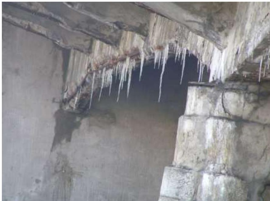
Рис.1.13 Фильтрация воды через монолитную и фасадную балки Купеческого моста г. Харькова
