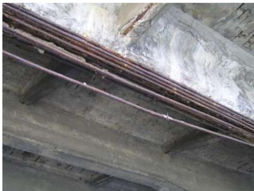
Рис. 4.14. Разрушение фасадной балки Купеческого моста в г. Харькове
