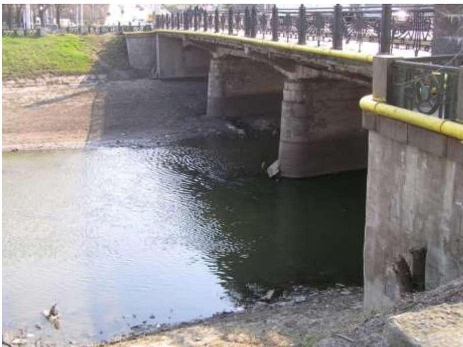
Рис. 1.16 Общий вид городского моста с газопроводом, который закреплен к аварийному тротуару
