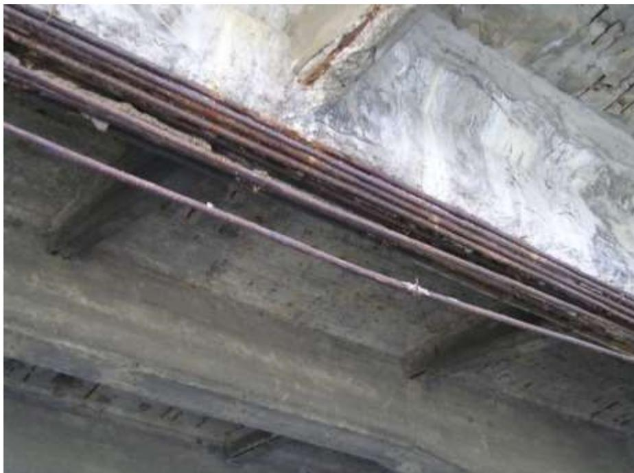
Рис. 1.14 Разрушение фасадной балки с уменьшением ее высоты под тротуаром Купеческого моста г. Харькова
