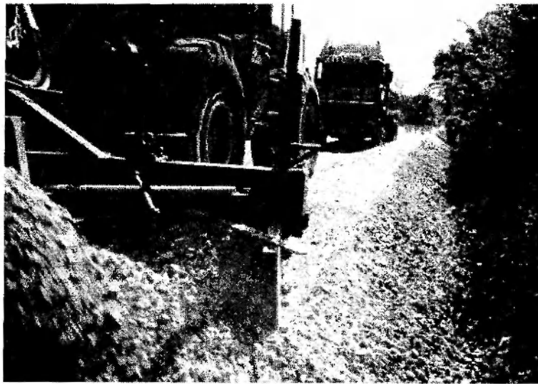
Рис. 2.16. Розширення існуючого покриття із застосуванням щебеневої суміші
