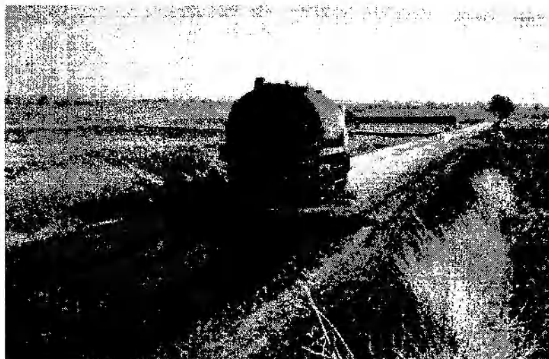
Рис. 2.25. Розподіл бітумної емульсії для догляду за покриттям
