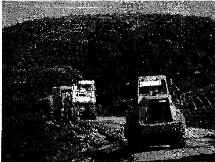
Рис. 2.3. Ущільнення рецикльованого матеріалу
